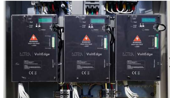
Dimming module DITRA VoltEdge
